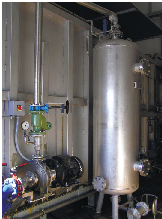
Рис. 2. Комплект VODACO-SAT на предприятии переработки мясных продуктов
